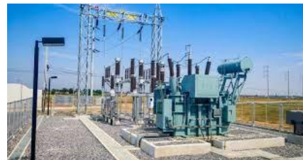
分支变电站 Sub-station electricity
